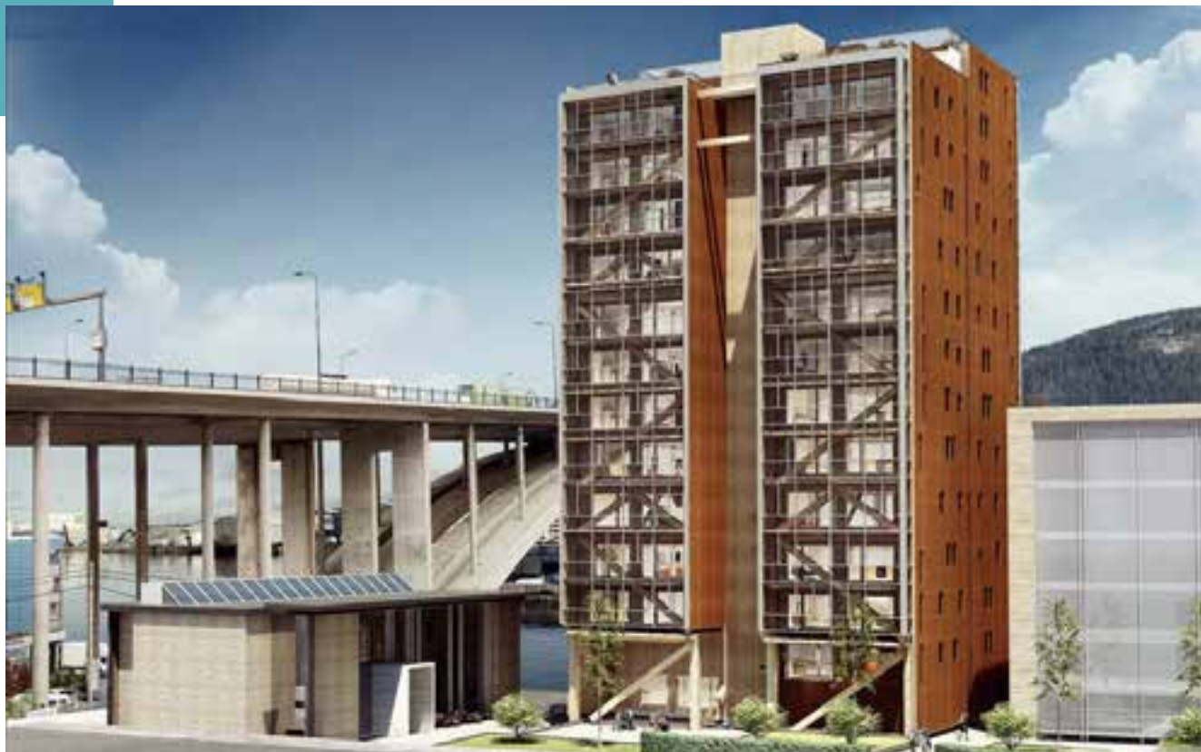
Imagem 11: Edifício Treet, em Bergen, Noruega. Estrutura mista de CLT e concreto. Projeto de Artec AS.
