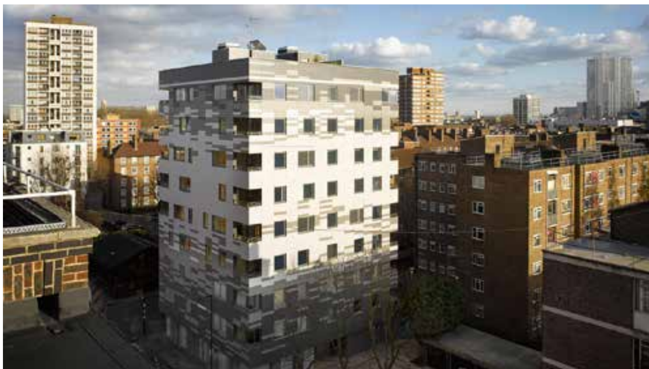
Imagem 12: Edifício Murray Grove, em Londres, Inglaterra. Estrutura mista de CLT e concreto. Projeto de Waugh Thistleton Architects.
