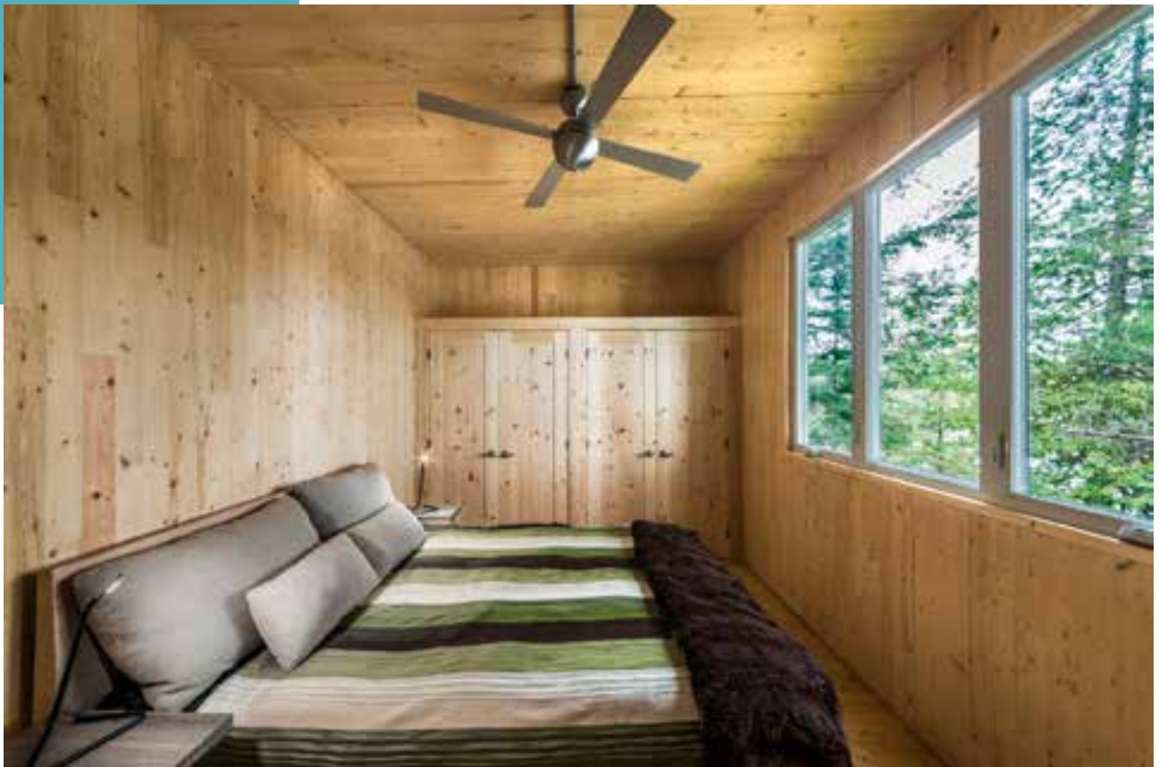
Imagem 7: Interior de uma construção em CLT sem revestimento, projeto de Kariouk Associates
